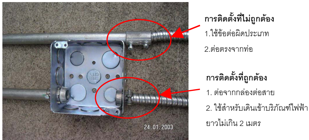
รูปที่ 7-10 การติดตั้งท่อร้อยสายชนิดโลหะอ่อน
