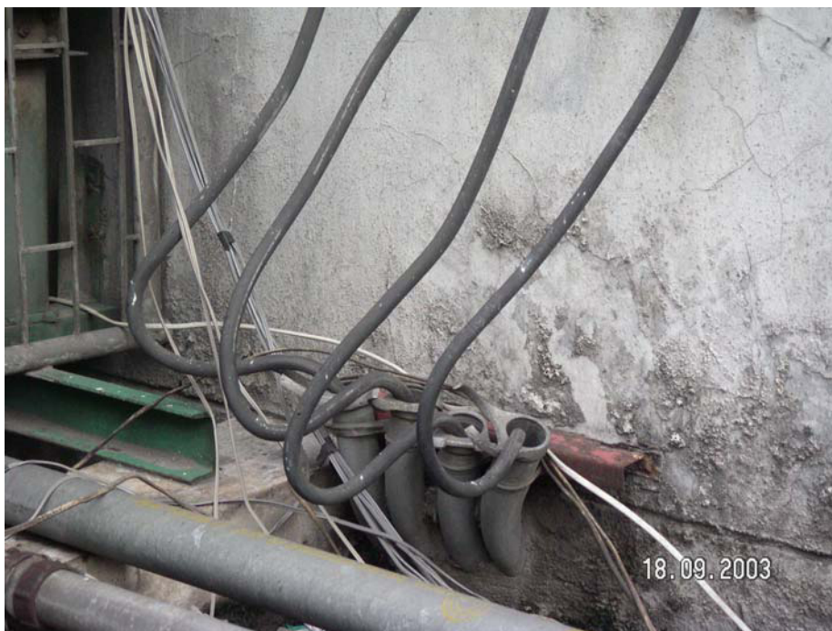
รูปที่ 7-2 วิธีการเดินสายแยกท่อโลหะที่ผิดมาตรฐาน
